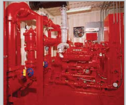
Unidad Pre-pac en una cubierta.
